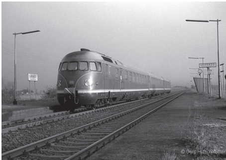
Bahnhof Leiferde West
