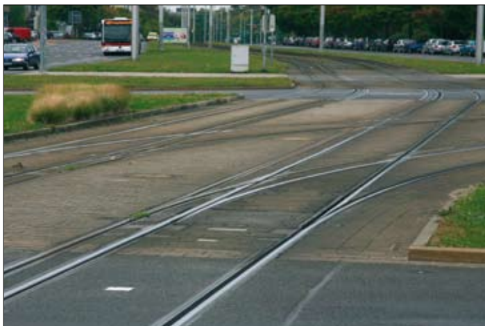
■ Seit vielen Jahren ist Braunschweig schon auf die RegioStadtBahn vorbereitet. Die vorgesehenen Trassen sind bereits zu einem guten Teil mit den notwendigen breiten Spuren ausgestattet. Das hat Millionen gekostet. Foto: A. Gräbner
