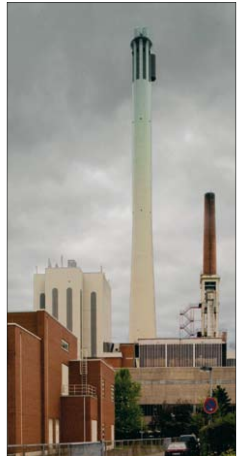
Im Heizkraftwerk Mitte wird eine neue Gas- und Dampfturbine zur Kraft-Wärme-Kopplung errichtet. Foto A. Gräbner
